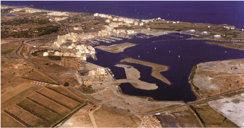
La station en construction en 1974
