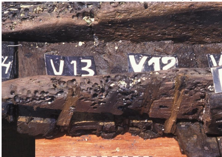
Fig. 3, site Baie de l'Amitié : assemblage par ligatures
