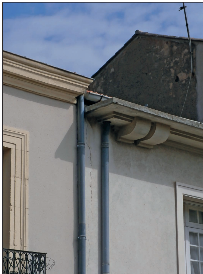
Photo 6 : Corniche et descente d'eau d'une maison de Clermont.
