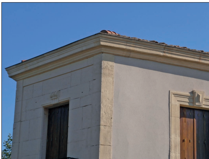
Photo 5 : corniche d'une maison de Clermont.
