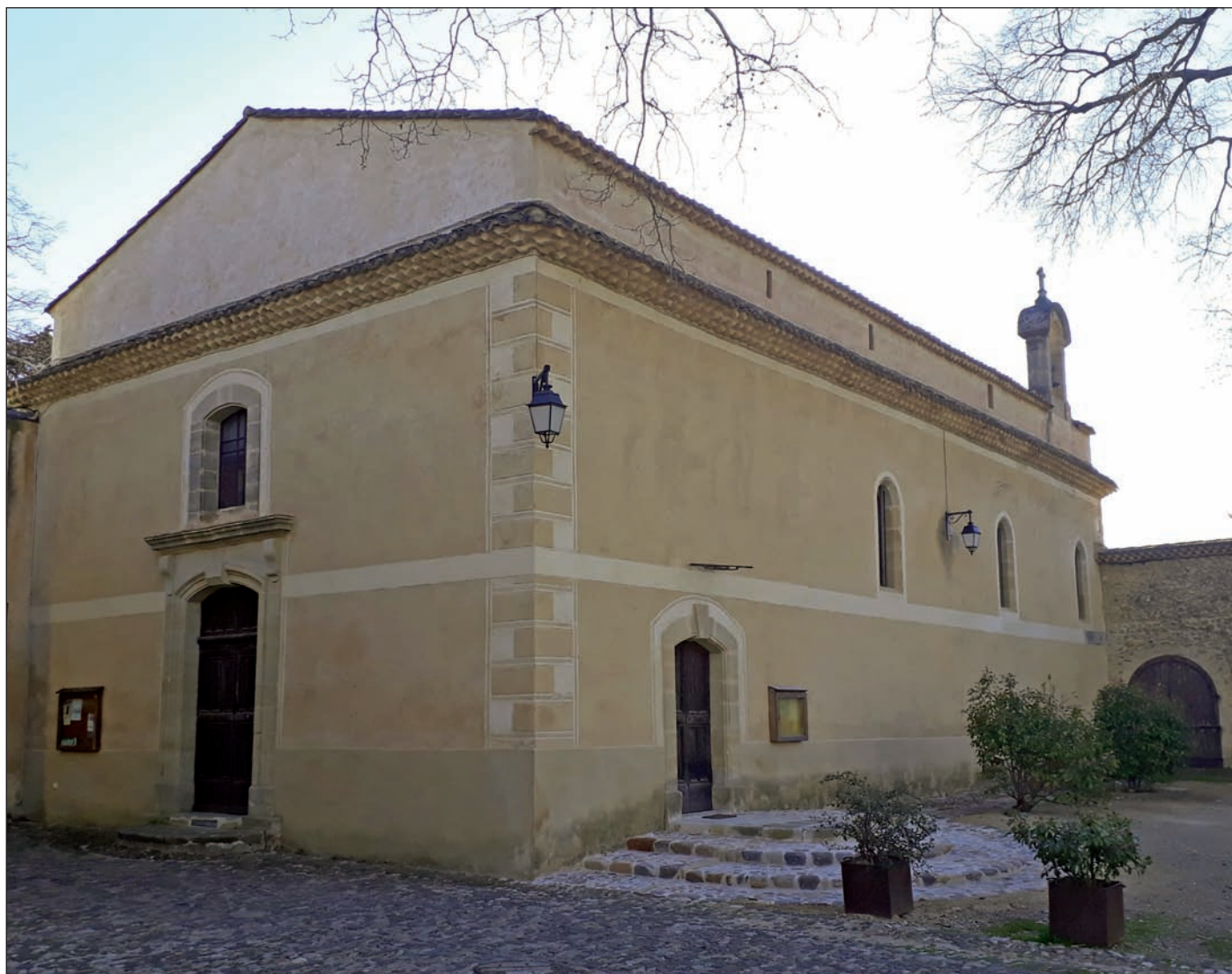
L'église, restaurée, avec son enduit XVIIIe fouetté à la branche de buis.
