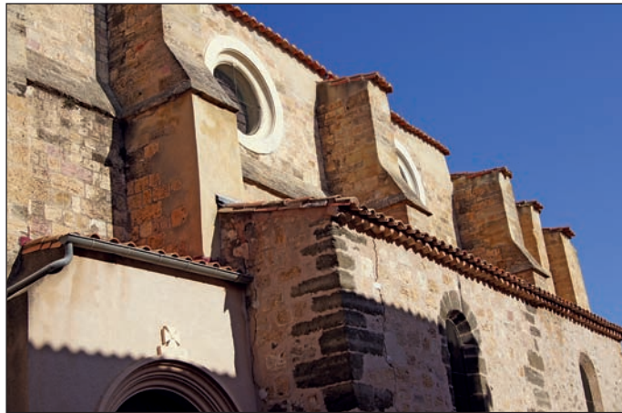
11 Le mur sud.
