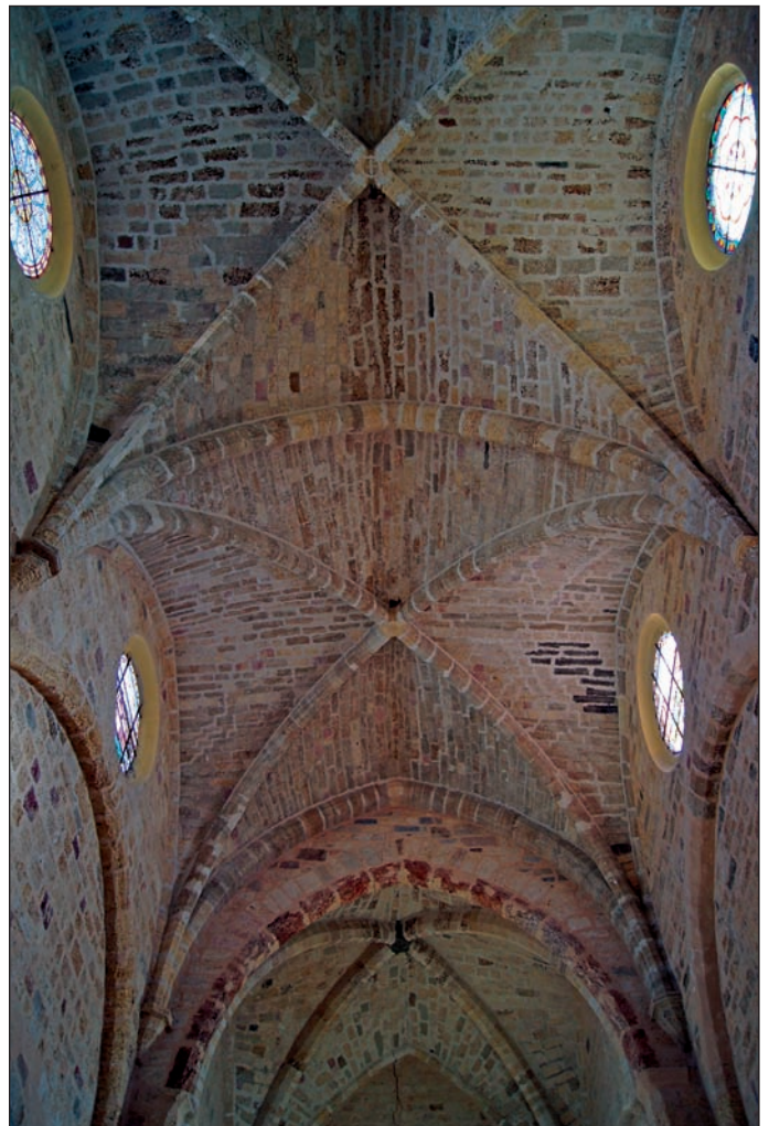
10 Les voûtes gothiques.
