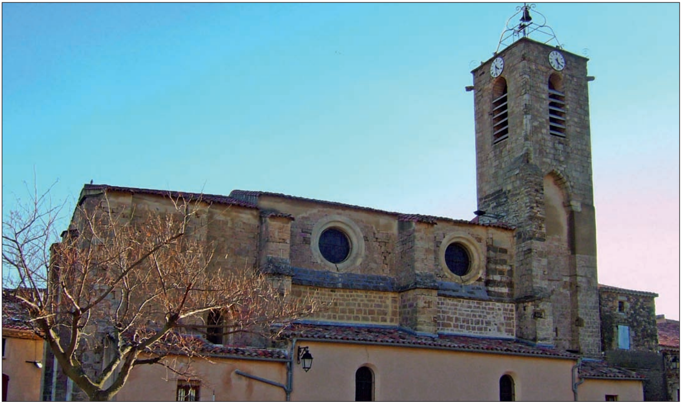
4 Vue de l'église côté nord.
