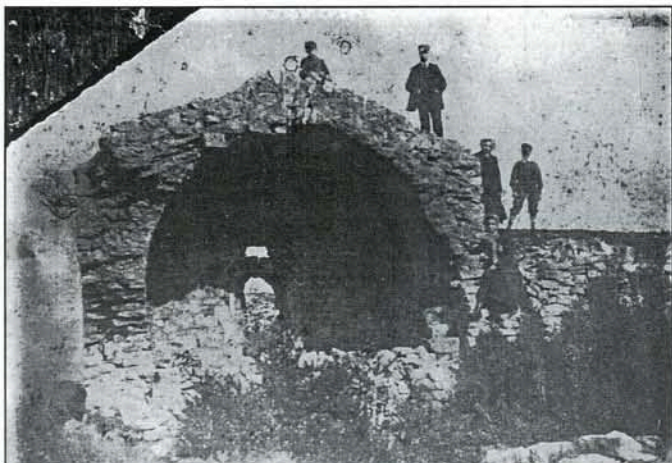
Reste de la chapelle. Une vieille fresque couvrant le mur de fond. Elle n'est pas visible sur cette photographie qui aurait été prise le 20 avril 1911.
