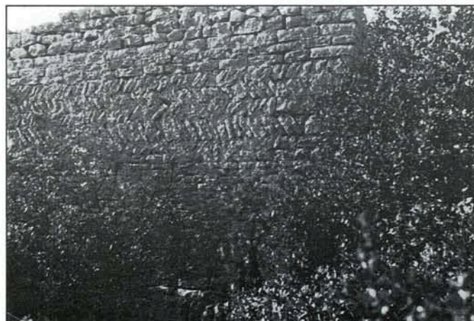
Ruines de l'ermitage. Saint-Jean Baptiste du Mont Liausson. Détails de l'appareillage d'un mur XII ème - XIII ème siècle. De bas en haut, petit appareil; appareil en épi (opus spicatum); appareil moyen. Photo prise le 20 mai 1962.
