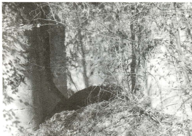
Débouché voûté du canal de fuite.
