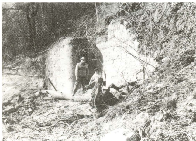
Sortie du canal de fuite avant la construction du barrage.
