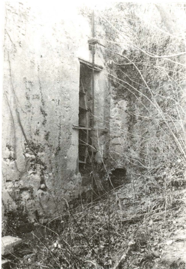
Meuse des Lores à Paulhan : entrée du canal d'amenée, avec la roue et la vanne, face au nord.
