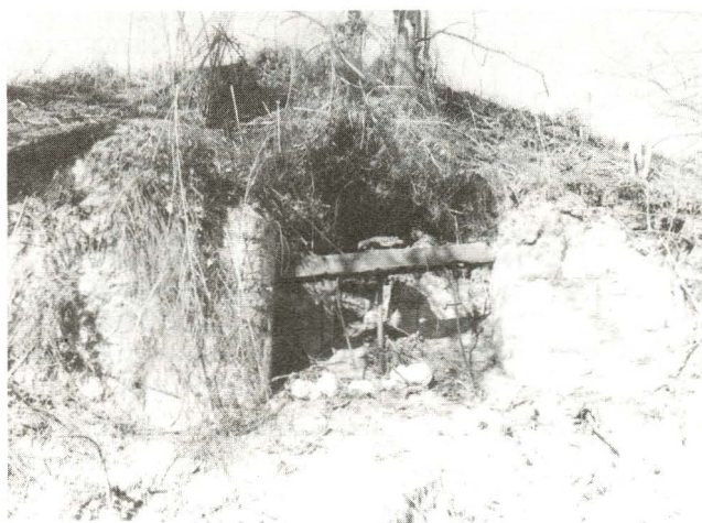
Entrée du canal d'amenée : le mécanisme de la vanne est encore en place.
