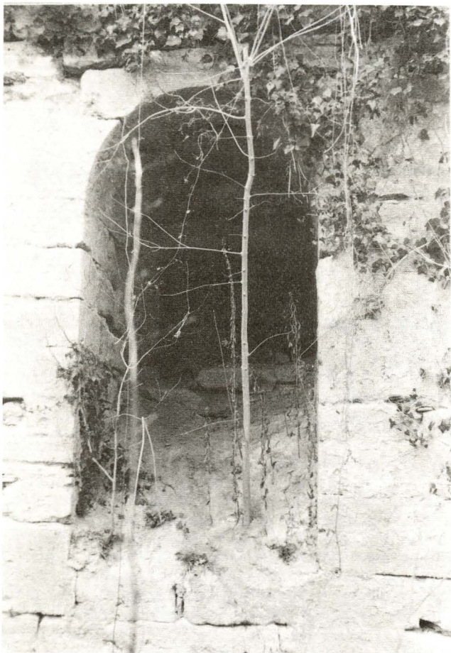
Meuse de Paulhan : orifice d'évacuation des eaux, face à l'est.
