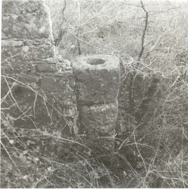
6 - Moulin du Vernoubrel : tambours cylindriques de la trompe.
