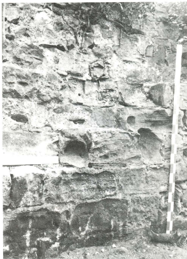
(12) Versant ouest. Mur antique. Détail du parement
