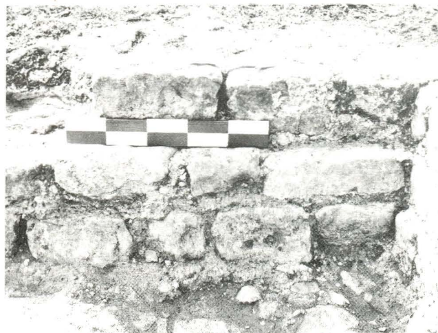
(4) Donjon. Angle de fondation de mur avec assise supérieure en retrait de 0,10 m par rapport aux deux autres
