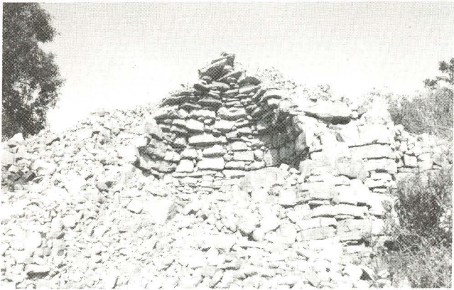
Abri éboulé laissant voir, en coupe, sa structure
