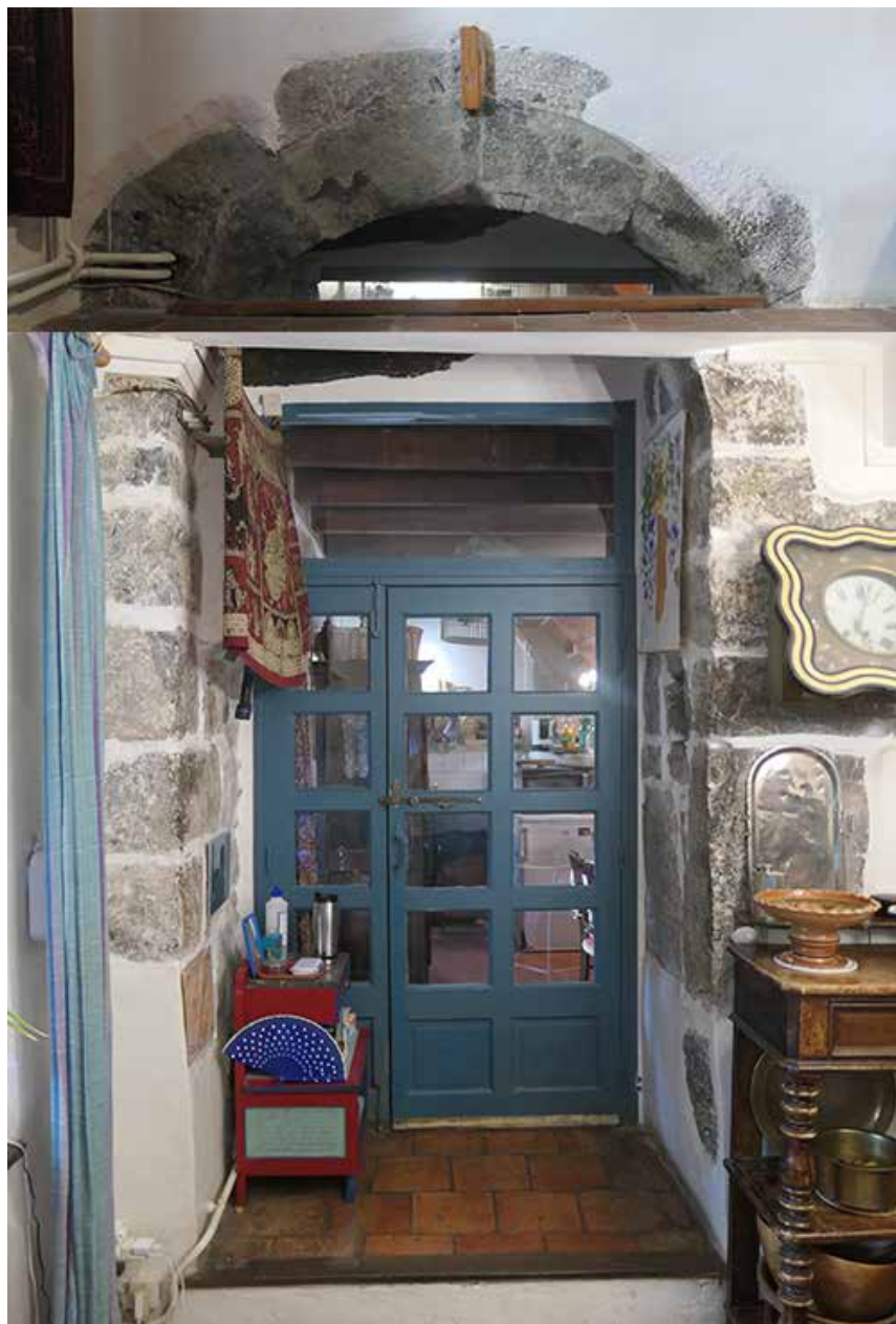
maison 1516 au 3 rue du Synode: la porte d'entrée d'origine occupe deux niveaux.
