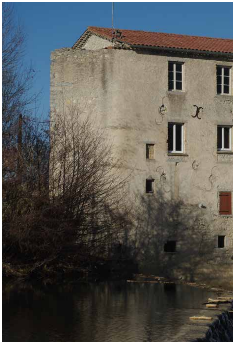
Face au courant, l'éperon massif qui divise les eaux en cas de crue.
