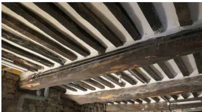
Plafond de la cave de la maison numéro 1503
