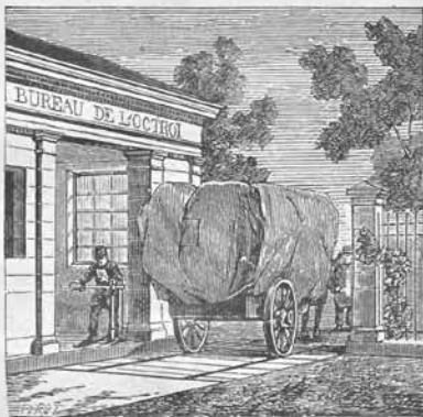
OCTROI ET BASCULE. — Aux portes de toutes les villes sont des bureaux d'octroi où l'on doit payer les droits d'entrée sur les marchandises. — Pour peser les voitures et fixer le poids des marchandises qu'elles portent, on les fait passer sur la plate-forme d'une bascule. Cette plate-forme, à l'aide d'un levier, soulève le fléau d'une balance qui se trouve à l'intérieur du bureau d'octroi, et l'employé lit, sur le bras de fer, le nombre de kilogrammes.
