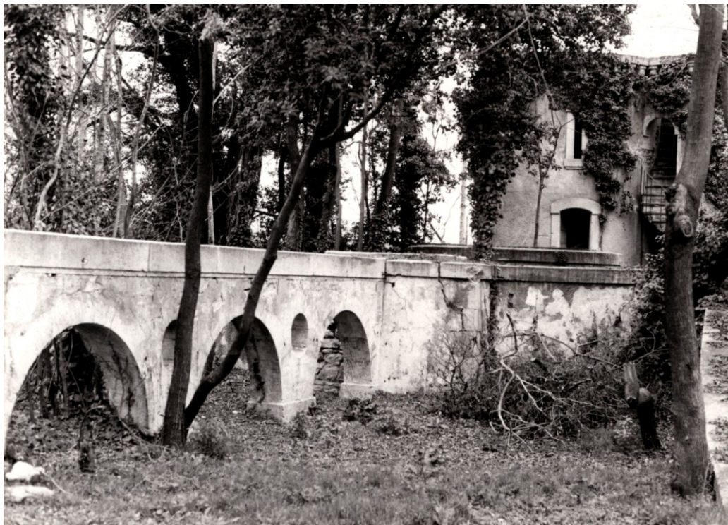
Fig. 96 - État de dégradation du moulin et de l'aqueduc en 1990. © Jean-Louis GIRARD.
