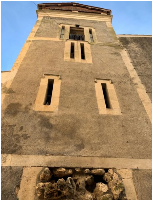
Fig. 54 - Réservoir en limite sud du château (2021). © Isabelle CELLIER.
