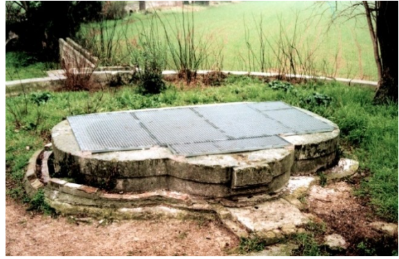
Fig. 59 - Puits à noria du moulin. Observer le départ de l'aqueduc à l'arrière-plan (1993). © Jean-Louis GIRARD.
