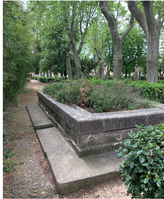
Fig. 68 - Plantations dans l'ancien lavoir (2023). © Isabelle CELLIER.
