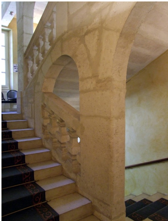
Fig. 5 - L'escalier monumental du XVII e siècle (1994). © Claude RAYNAUD.
