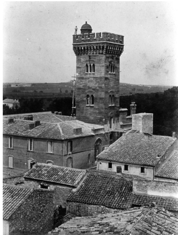
Fig. 11 - La tour du château en fin de chantier en 1896 ; un échafaudage est encore en place sur la face nord de la tour. Carte postale. © Fonds Manse.
