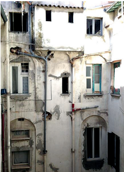
Fig. 15 - Travaux de restauration rue Gaveau
