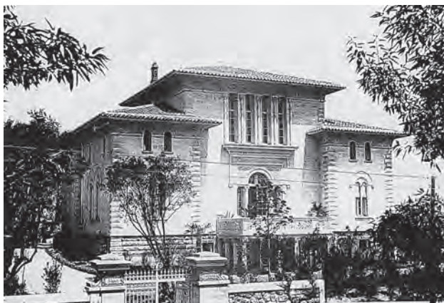
Fig. 1. La villa Harmonie à Montpellier, architecte Emile Leenhardt. (cliché Chateaufort)
