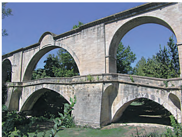
Fig. 1. L'aqueduc de Carpentras illustre la renommée de Clapiès au-delà du Languedoc. (© Philip Bourret 2005, licence Structurae)
