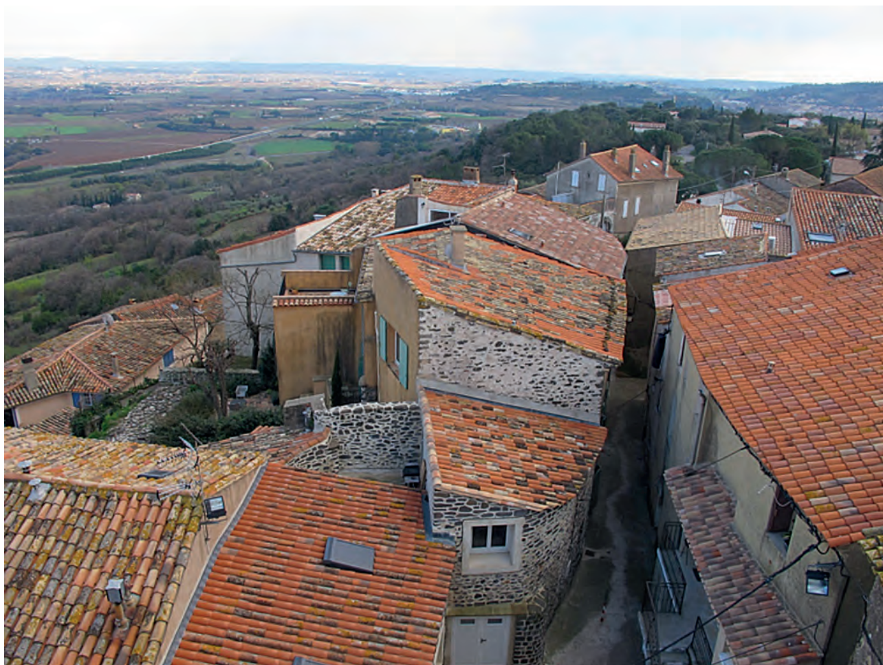
Bâti traditionnel rural : le village de Lacoste. (Cliché EH).
