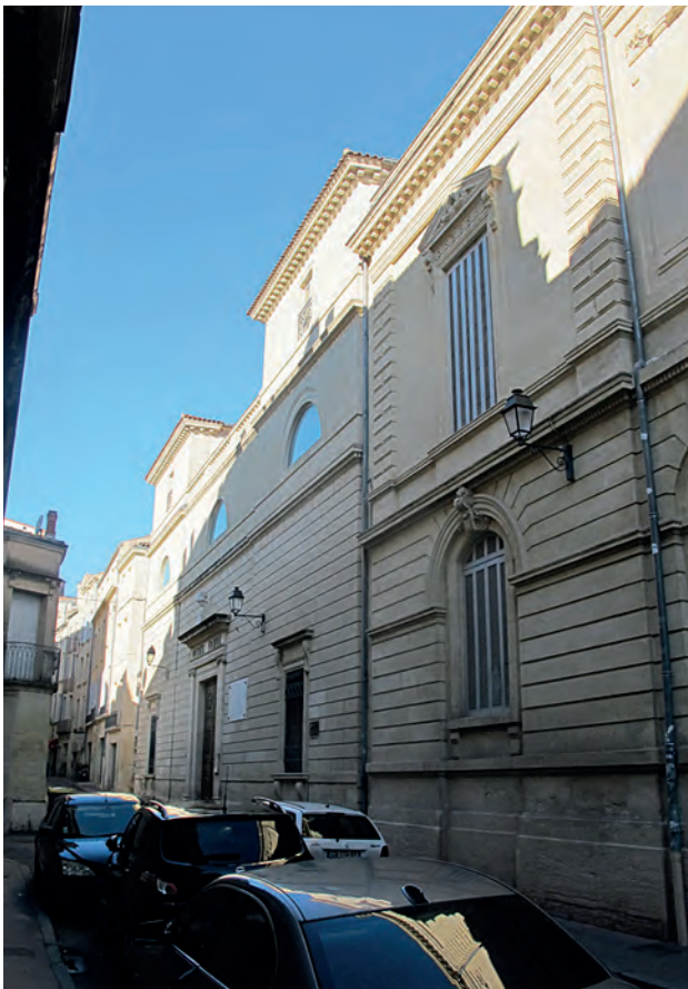
Fig. 2. L'hôtel de Massilian, rue Montpelliérêt, très probable siège de l'école des ponts et chaussées. (Cliché EH).
