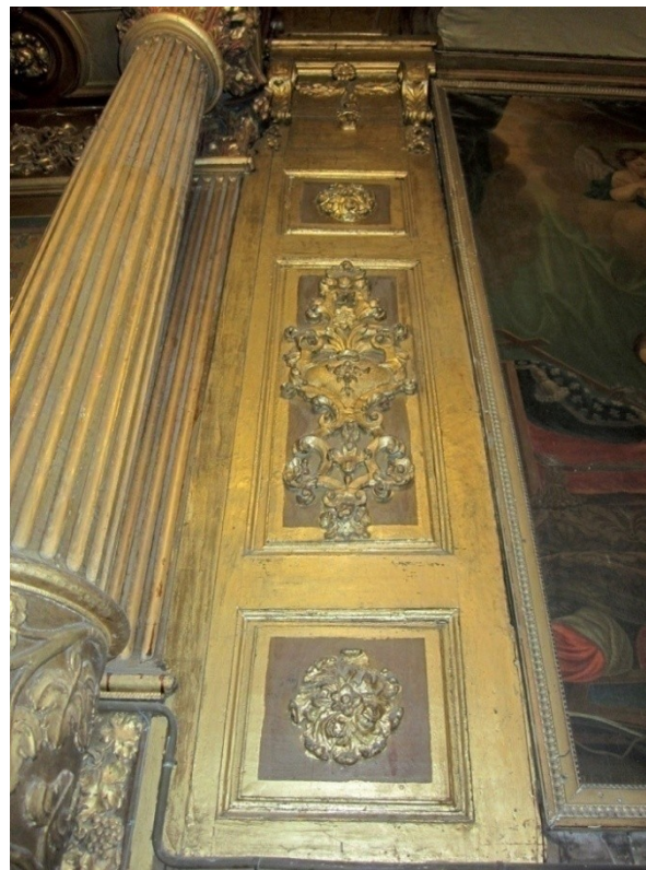
Fig. 13 - Chapelle des Pénitents Blancs, détail du lambris de revêtement.
