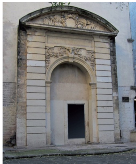
Fig. 4 - Anciennes casernes des Minimes, porte centrale. Montpellier, place Notre-Dame-des-Tables.
