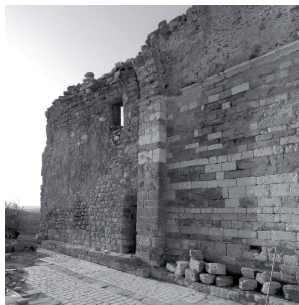
Fig. 4 - Mur nord (© E. Garcia, 2012)
