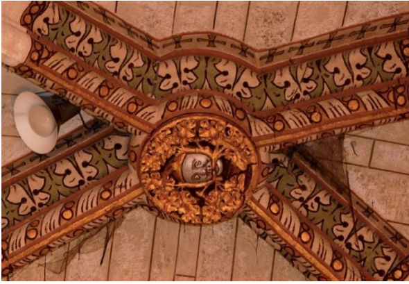
Fig. 5 - Clef de voûte de la chapelle latérale sud.
