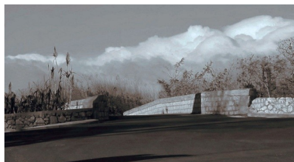
Fig. 2 - Montpellier, le pont de Cholet
