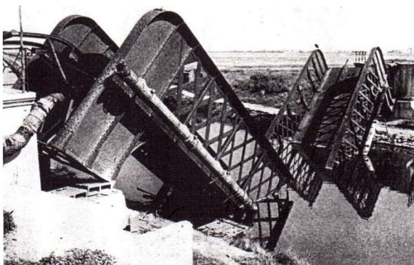
Fig. 10 - Le pont de 29 mètres d'ouverture sur le canal du Rhône à Sète (ligne Montpellier-Palavas) après sa destruction par les Allemands dans la nuit du 18 au 19 août 1944.
