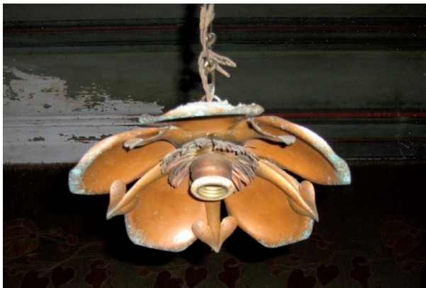
Fig. 10 - Luminaire en cuivre martelé de la chambre de l'appartement (Ph. L. Félix).
