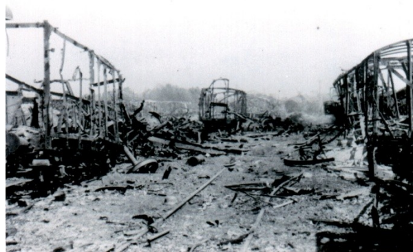
Fig. 8 et 9 - La gare de triage de Montpellier-Arènes (SNCF) après le bombardement allié du 5 juillet 1944.
