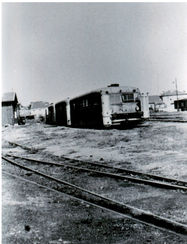
Fig. 3 et 4 - Aux ateliers de Montpellier-Chaptal, autorails série M 101 à 105 (De Dion, 1938) du réseau SE de la Franche-Comté repliés dans l'Hérault et équipés d'un gazogène en 1942. Trois appareils de cette série reviendront à Montpellier en 1966 pour rouler sur la ligne de Palavas jusqu'à sa fermeture, en 1968.
