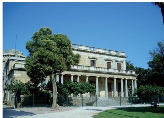
Fig. 02 - Vue actuelle de la façade à perron et péristyle (Ph. L. Félix).
