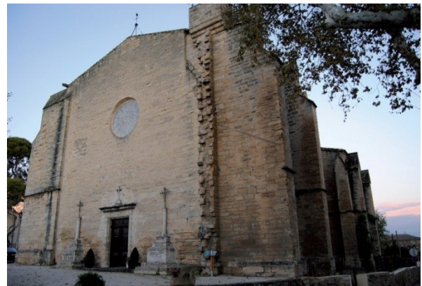
Fig. 7 - Vue de l'église prise depuis le sud-ouest.
