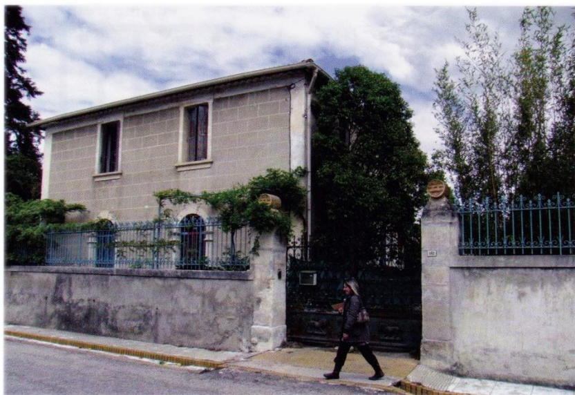
Fig. 9. Maison vigneronne à Boisseron dont les piliers du portail portent de petits foudres emblématiques ; la cave se trouve au fond du jardin (cl. Cl. Raynaud).
