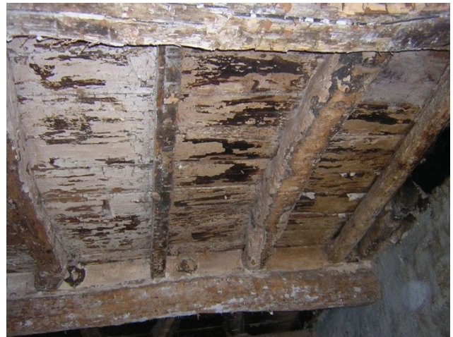
Fig. 3. – Poutres en bois soutenant le plafond du rez-de-chaussée, 19 rue d'Embonne, Agde. La poutre la plus éloignée, un tronc brut, appartient très probablement à un peuplier. Photo H. Groenendijk, 2003.
