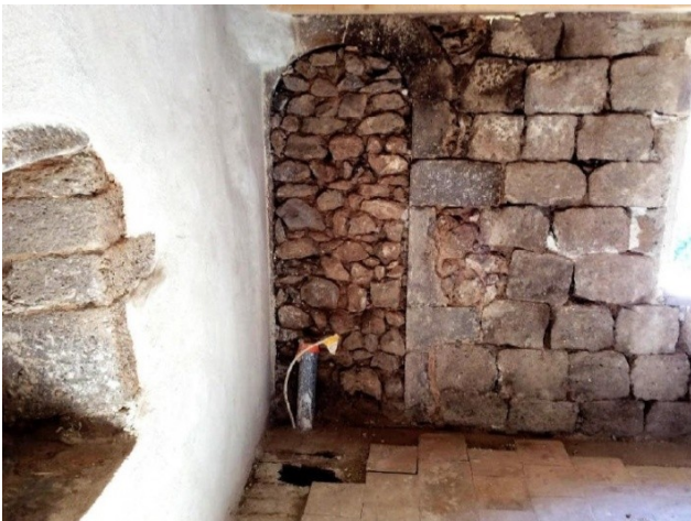
Fig. 2b. – Côté intérieur de la façade postérieure montrant un passage voûté correspondant à une porte au deuxième niveau de l'extérieur. Photo H. Groenendijk, 2017.
