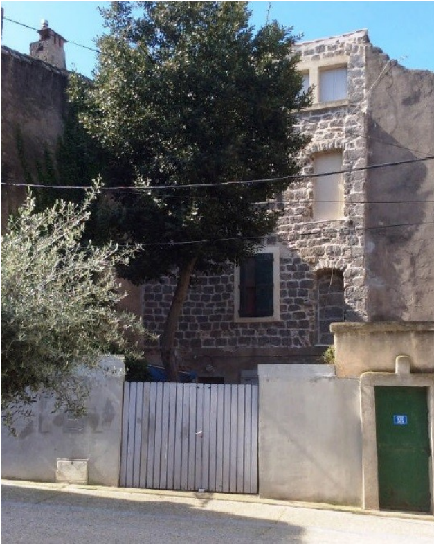
Fig. 2a – Façade postérieure du 19, rue d'Embonne, Agde, après enlèvement de l'enduit de revêtement et l'apparition des embrasures de porte. Photo H. Groenendijk, 2019.
