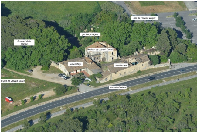
Fig. 12 - Vue aérienne resserrée de la Tuilerie de Massane, Grabels. (Cl. Alain Colombaud), 2017.
