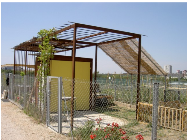
Fig. 26a, 26b - Juin 2006. À gauche, un an après l'installation de la pergola « officielle », celle de l'architecte est nue, remplacée par une excroissance entretenue par le jardinier. Une solution intermédiaire, à droite, consiste à conserver la couverture existante et à abaisser en l'inclinant sa partie voisine. Un classique parasol complète l'ensemble pour cette protection solaire à trois niveaux...
