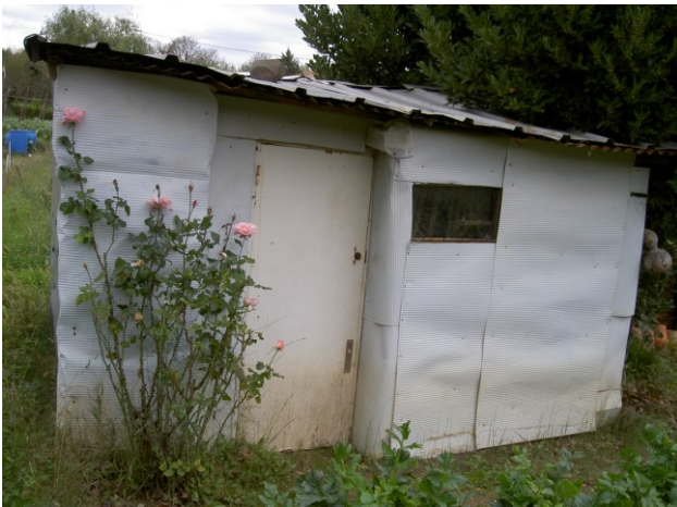
Fig. 4a Fig. 4b - La cabane de gauche présente une légère et élégante peau de métal déroulé, peut-être de l'aluminium provenant de l'entreprise Pechiney : un matériau souple, pliable, inoxydable... et vraisemblablement facile à se procurer pour ce jardinier. Cet autre abri, à droite, fait appel à des procédés de construction plus classiques.
