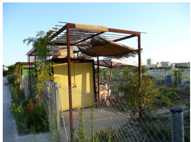
Fig. 26a, 26b - Juin 2006. À gauche, un an après l'installation de la pergola « officielle », celle de l'architecte est nue, remplacée par une excroissance entretenue par le jardinier. Une solution intermédiaire, à droite, consiste à conserver la couverture existante et à abaisser en l'inclinant sa partie voisine. Un classique parasol complète l'ensemble pour cette protection solaire à trois niveaux...
