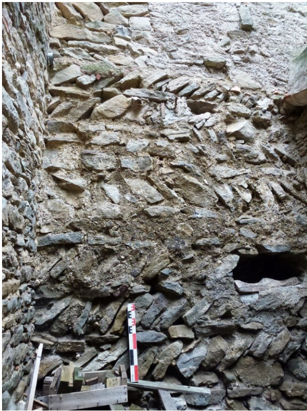
Fig. 5. Parement nord du mur préroman MR6a, à la base du mur MR26. On remarque les assises inclinées alternant avec des éléments plats. Cliché : F. Loppe, 2020.
