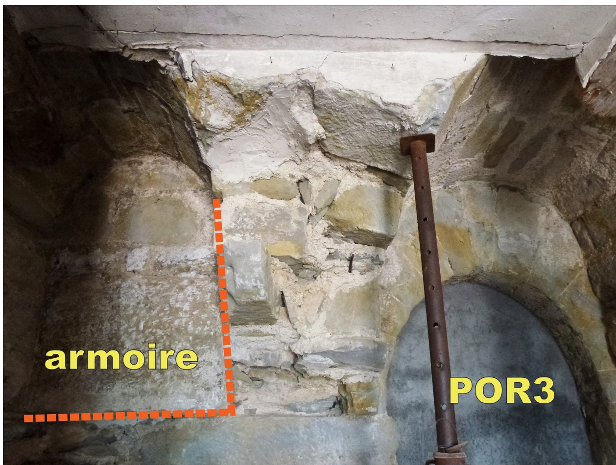
Fig. 24. Bâtiment III. Vue intérieure partielle du mur MR3, premier étage. On remarque à gauche l'armoïre partiellement conservée dans l'épaisseur du mur ainsi qu'à droite la partie supérieure de la porte POR3. Cliché : F. Loppe, 2020.
