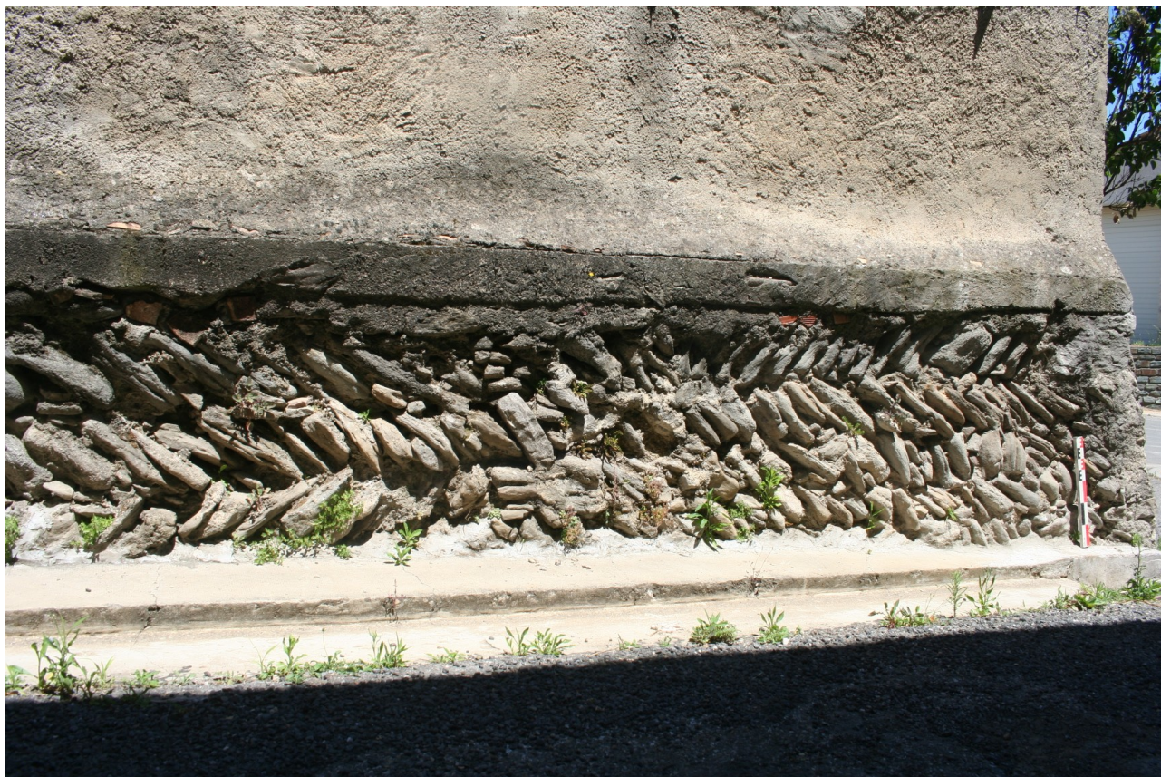
Fig. 19. Mur MR28 de la première enceinte villageoise, parement intérieur sud. Vestige d'appareil en opus spicatum . Cliché : F. Loppe, 2020.
