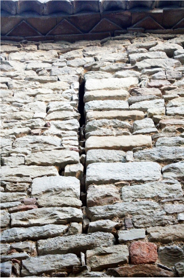
Fig. 27. Bâtiment IV, mur ouest MR12, premier étage. Vue extérieure de l'archère A1. Cliché : F. Loppe, 2020.
