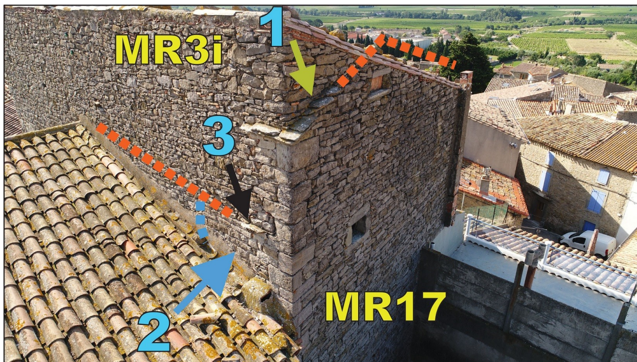
Fig. 25. Bâtiment III. Vue générale de l'angle extérieur nord-ouest (murs MR3 et MR17). 1. Lauzes matérialisant le niveau de toiture originel du bâtiment III. ; 2. vestige de mur médiéval MR3 ; 3. Lauze matérialisant le niveau de la toiture du bâtiment V (disparu). Cliché drone : S. Durand, Geoptère, 2021.
