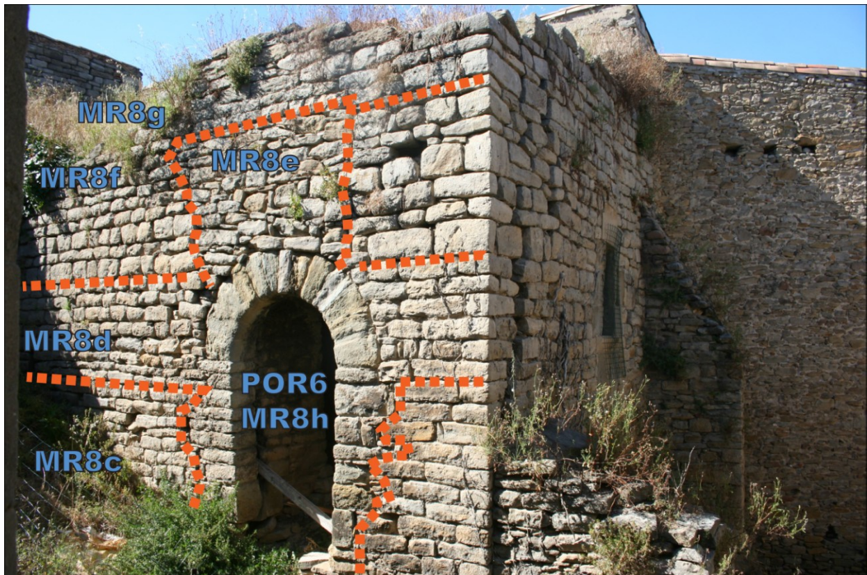
Fig. 16. Bâtiment I. Vue extérieure partielle du mur sud MR8. On remarque les diverses phases de construction et l'ancrage a posteriori de la porte POR6. Cliché : F. Lophe, 2020.
