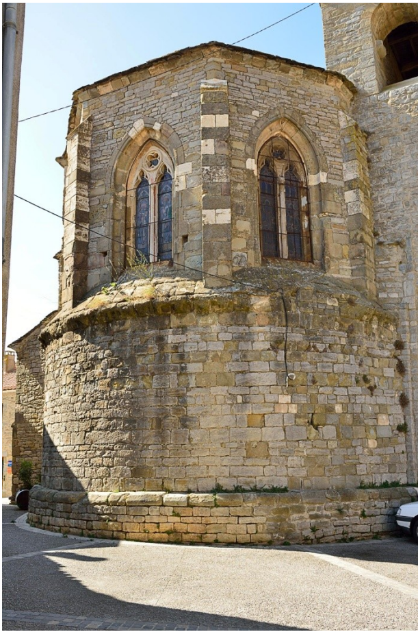
Fig. 3. Abside romane de l'église Saint-Etienne surélevée à l'époque gothique. Cliché : Ch. Douillet.
