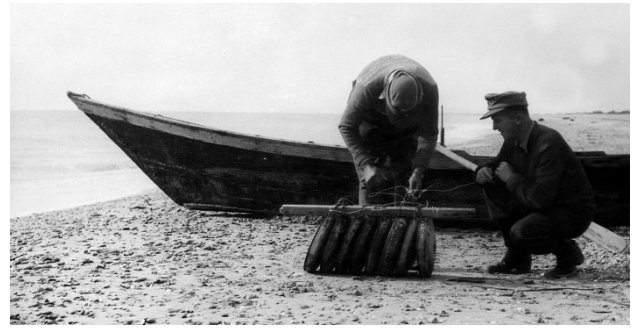
Fig. 5. La technique du « grenadage » utilisée pour l'explosion des mines immergées : les mines provenant des sols déminés sont mises en chapelet et réunies par un appareillage électrique pour exploser à l'endroit et au moment voulu, [1945], Archives départementales de l'Hérault, 173 J 19.
