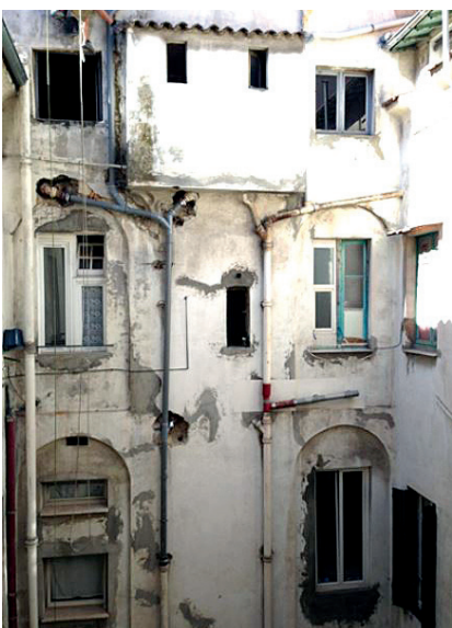
Fig. 15 - Travaux de restauration rue Gaveau
