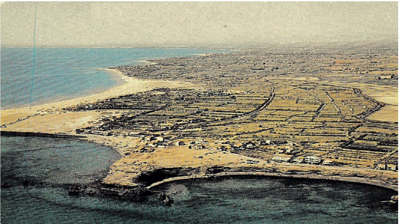
Photo n° 10 : Photo du Cap d'Agde avant les travaux de la Mission Racine.
