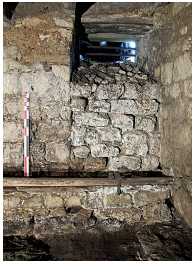
Fig. 15. Porte méridionale primitive remontée puis bouchée, vue depuis le nord (cliché A. Bergeret)
