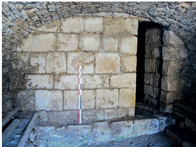
Fig. 6. Vue du parement extérieur du mur septentrional du chevet de l'ancienne chapelle, depuis le nord (cliché A. Bergeret)
