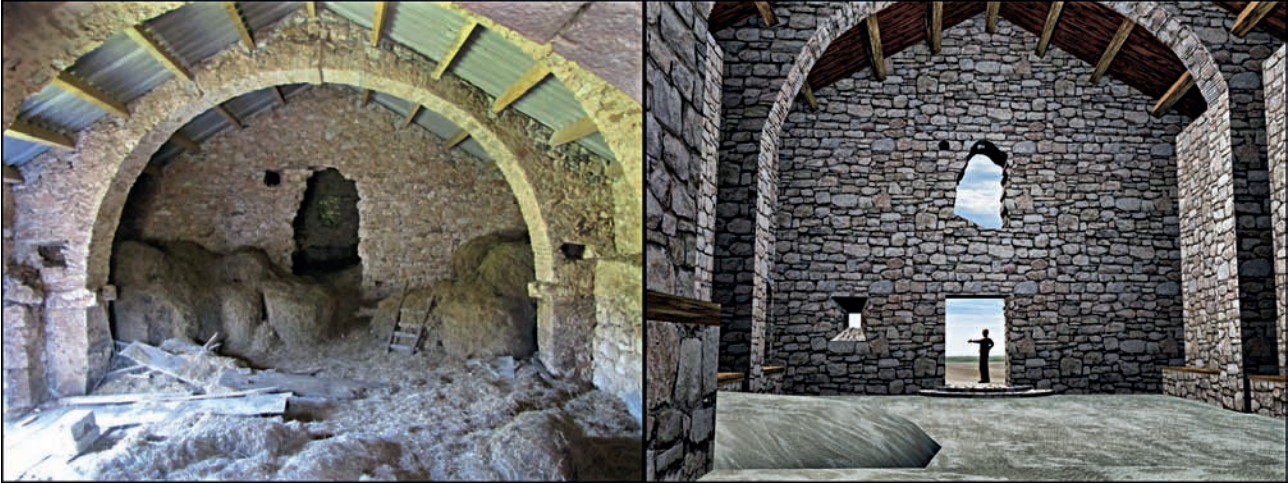
Fig. 26. Juxtaposition d'une photo du mur ouest actuel et sa restitution probable au XIIe siècle (cliché et 3D P.Cervellin)
