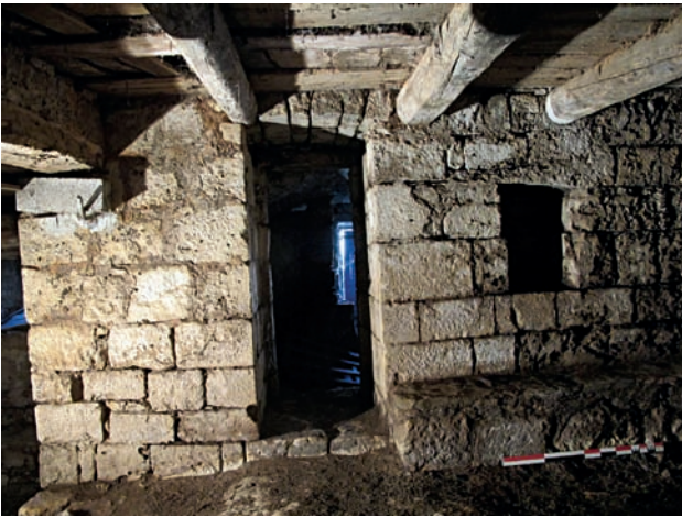
Fig. 16. Mur septentrional du chevet de l'ancienne chapelle, depuis le sud (cliché A. Bergeret)
