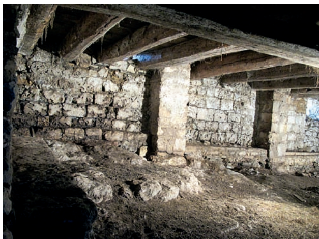
Fig. 8. Vue d'ensemble du parement intérieur du mur méridional de la nef de l'ancienne chapelle encore en élévation, depuis le nord-est (cliché A. Bergeret)
