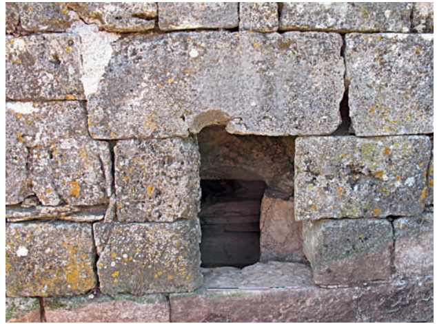
Fig. 17. Fenêtre ouverte dans le mur oriental du chevet, vue depuis l'est (cliché A. Bergeret)
