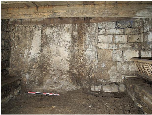
Fig. 12. Mur oriental du chevet de l'ancienne chapelle en élévation, depuis l'ouest (cliché A. Bergeret)
