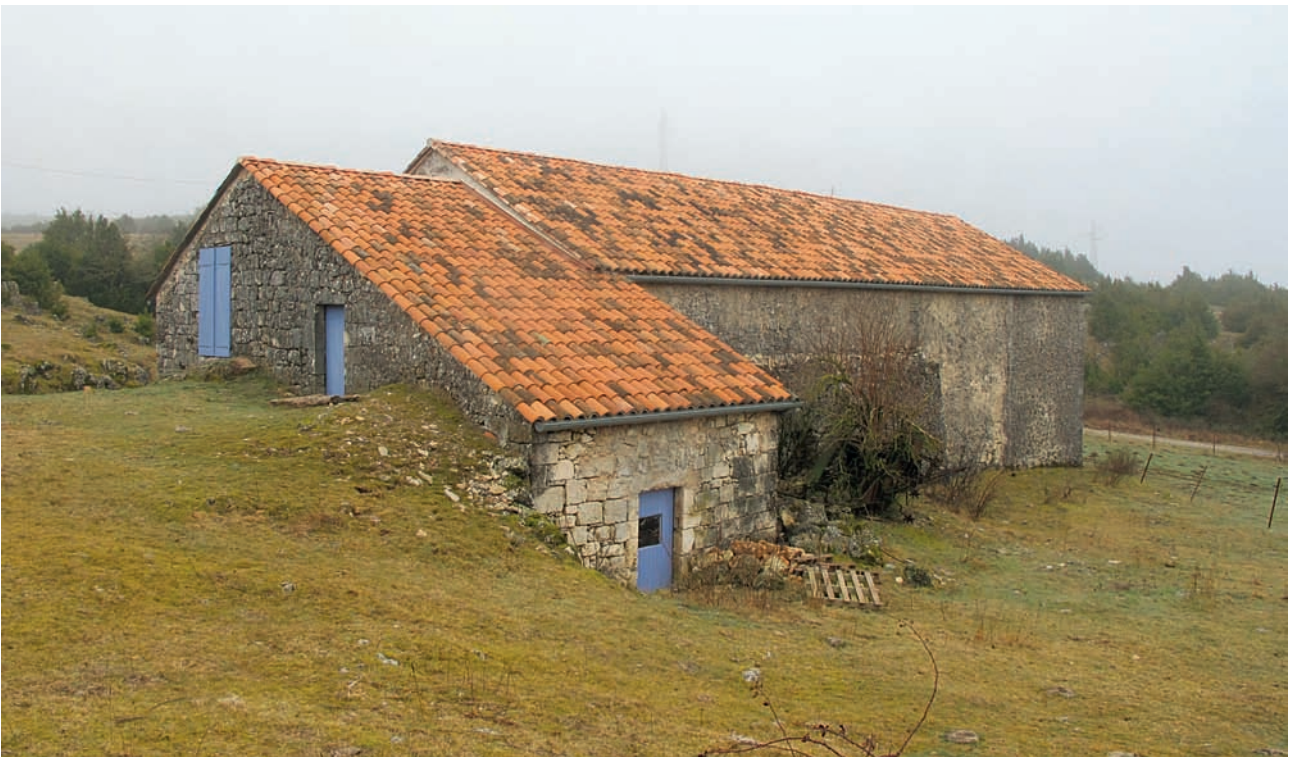
Fig. 2. Le site dans son cadre, vue depuis le nord-est (cliché A. Bergeret)
