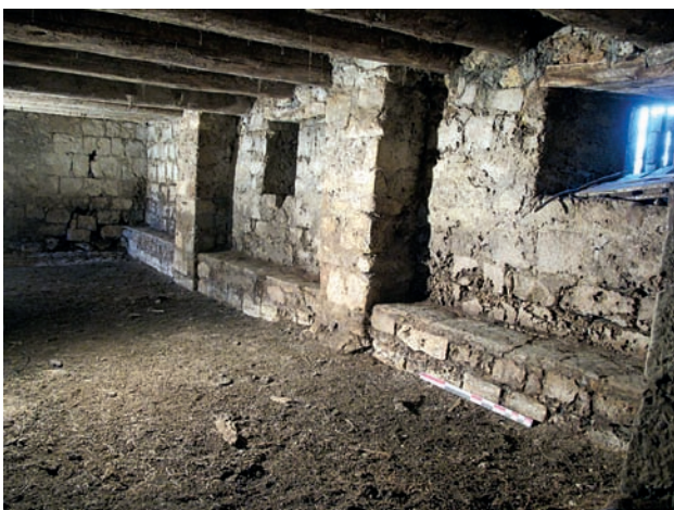
Fig. 7. Vue d'ensemble du parement intérieur du mur septentrional de la nef de l'ancienne chapelle encore en élévation, depuis le sud-est (cliché A. Bergeret)
