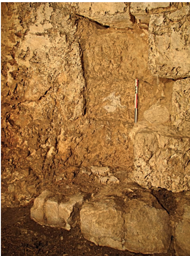
Fig. 14. Détail des encoches pratiquées dans le rocher afin de caler les queues des pierres de parement du mur oriental de la chapelle en élévation, depuis le sud-ouest (cliché, A. Bergeret)
