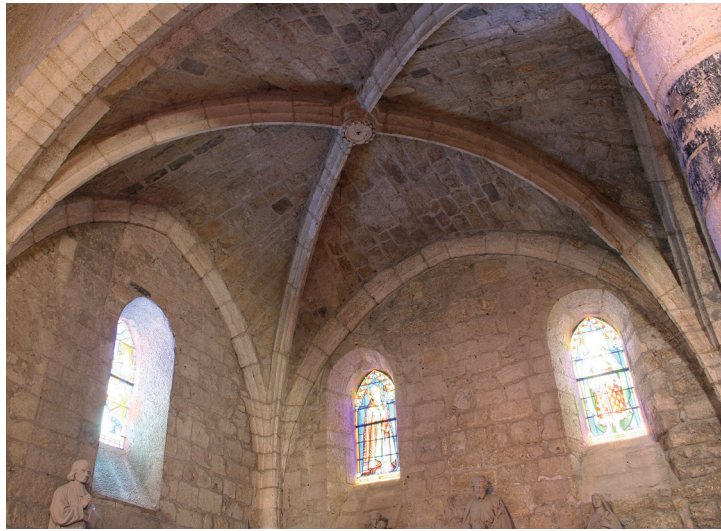
Fig. 17. Chapelle Notre-Dame. Baies de style gothique et voûte sur croisées d'ogives chanfreinées.
