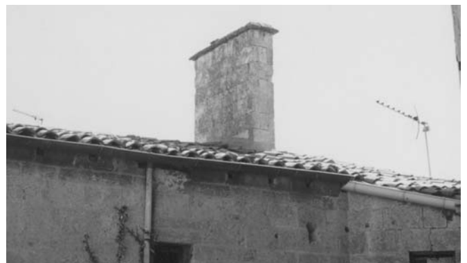
Fig. 7 : Conduit de fumée extérieur de la cheminée.
