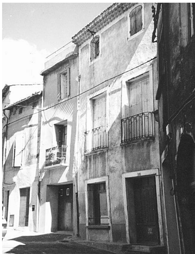
Fig. 4 : Façade nord. L'aspect médiéval du château a disparu sous les enduits. On note toutefois la grande largeur des baies du premier étage de la première maison. Ce sont des fenêtres à croisée transformées au 18e siècle.
