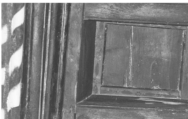
Fig. 9 : Détail du plafond à caissons de la grande salle avant décapage. Moulure haute, planchette de bas de solives, solives, planchettes de haut de solives, couvre-joints et planches. Les guirlandes de fleurs sur fond rouge sont à peine visibles.
