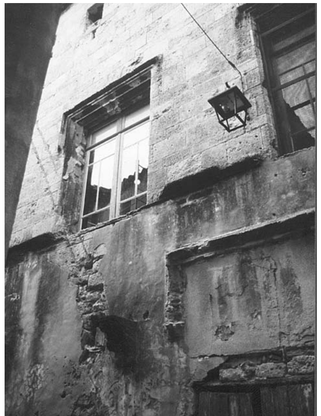
Fig. 2 : Façade ouest. Fenêtres à croisée (disparue) dans un mur en appareil de Montpellier. 2 e période.
