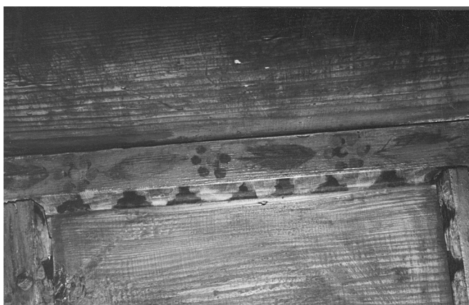
Fig. 12 : Le plafond à caissons après décapage. Détail de la décoration des couvre joints. Les clous qui maintiennent les planchettes (en les brisant) ne sont pas d'origine.
