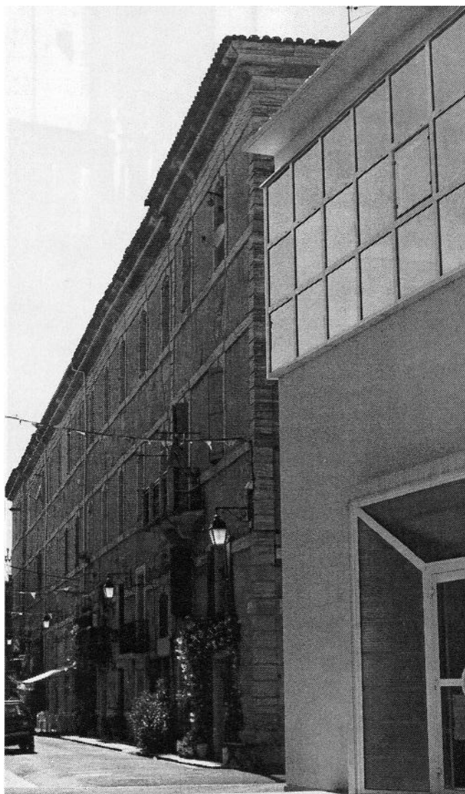
Fig. 10. - La façade du bâtiment du dortoir. Le rez-de-chaussée a été depuis lors partagé en deux niveaux. Il subsiste quelques cellules encore intactes.
