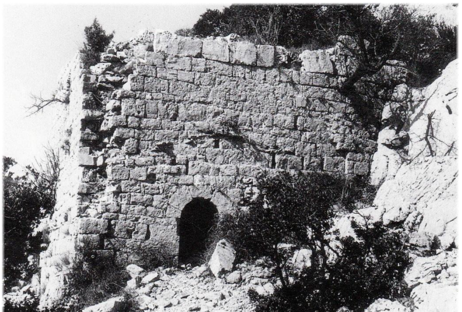
Le bâtiment inférieur de Roque Faran, vu de l'est.
