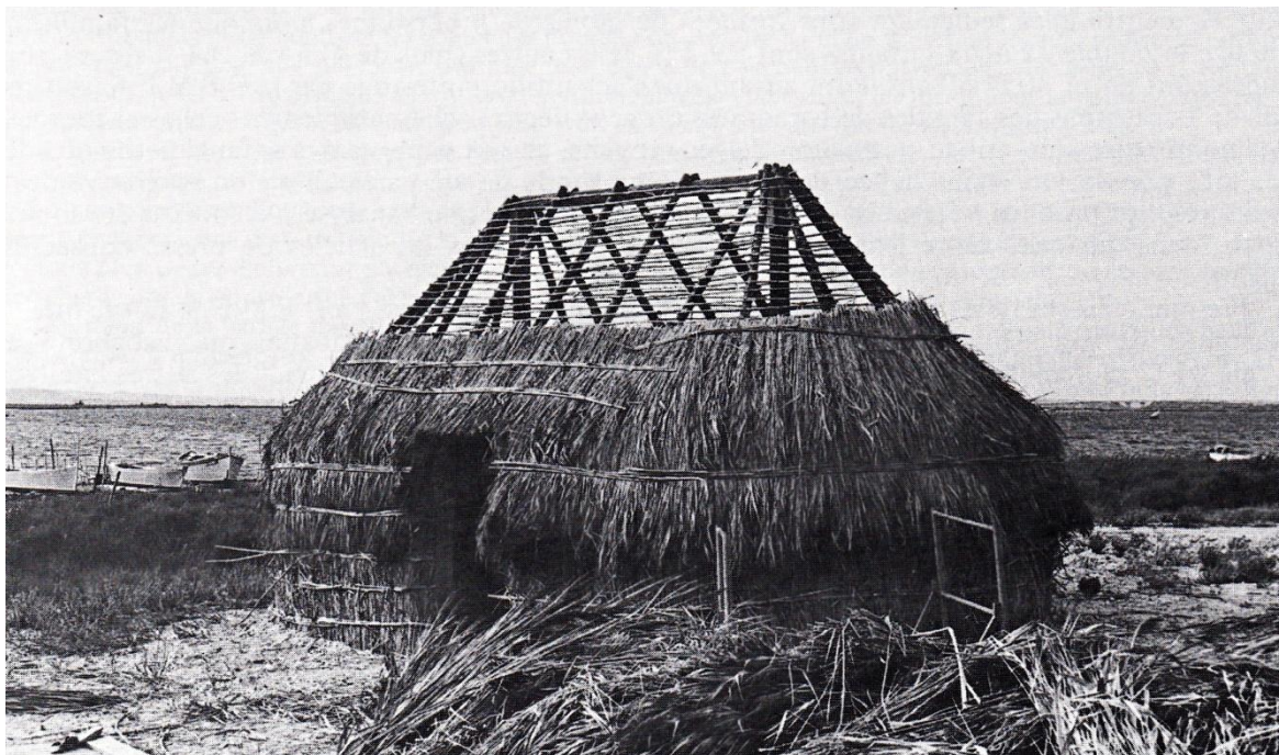
Construction d'une paillote sur le littoral languedocien. (Construction et photo : G. BALDET et B. GAUTIER).
