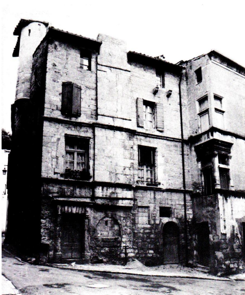
▼ Maison, rue A, P Allès, XVII ème siècle.
